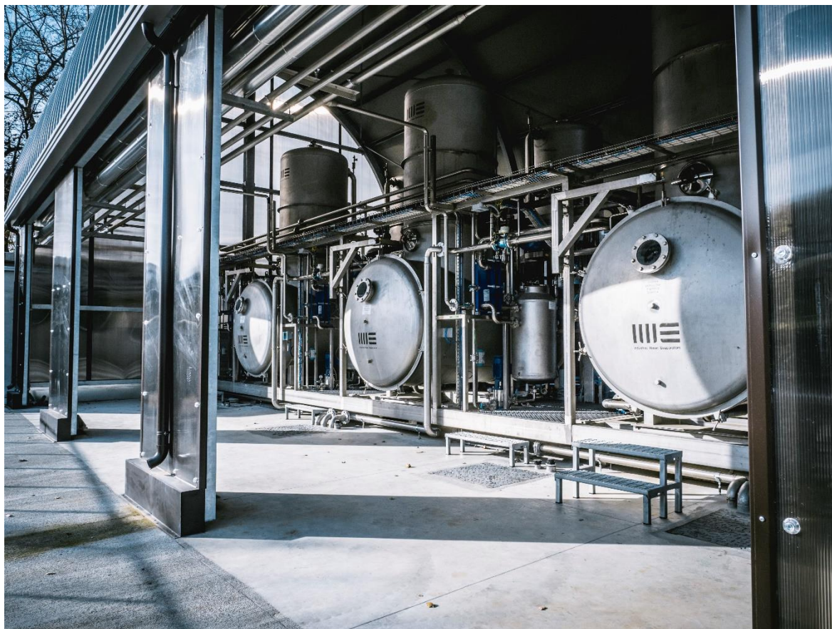
Figura 5: Impianto triplice effetto.
